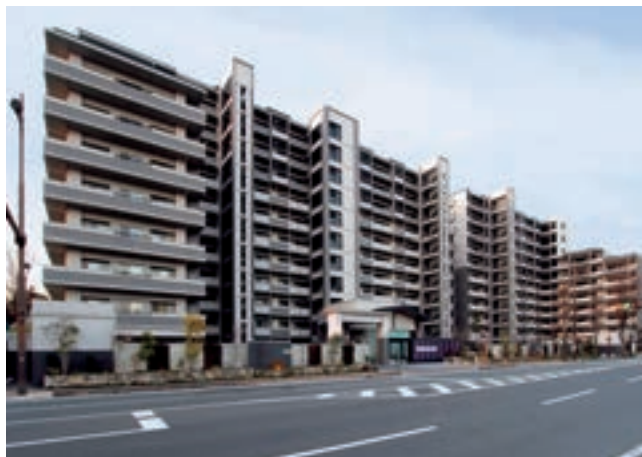
アンビール熊本城Ⅱ新築 (熊本県熊本市)
