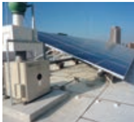
太陽光パネルの設置
