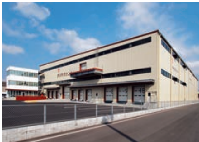
戸畑物流センター新築 (福岡県北九州市)
